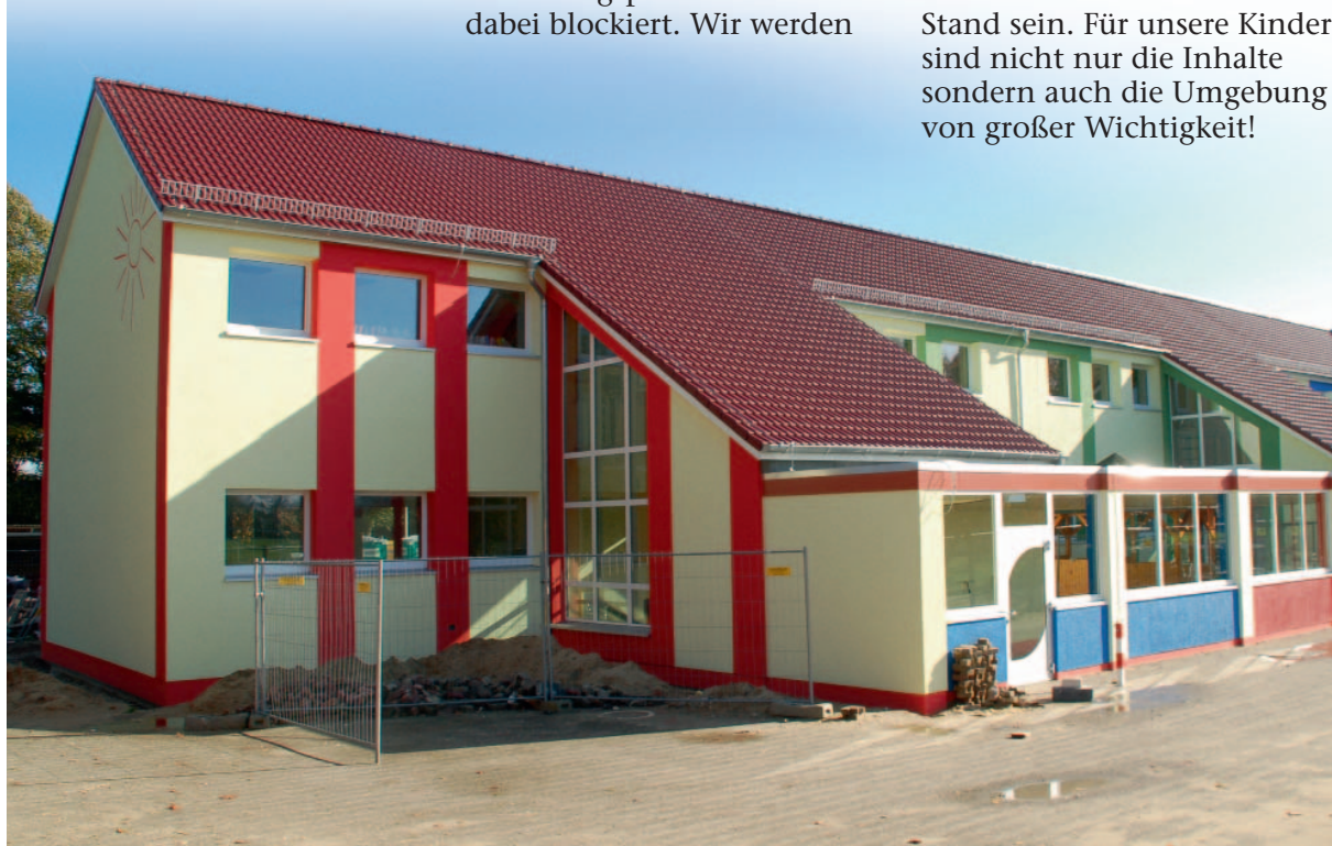
Farbenfroh präsentiert sich die frisch isolierte Fassade der Grundschule Neuenwalde.
